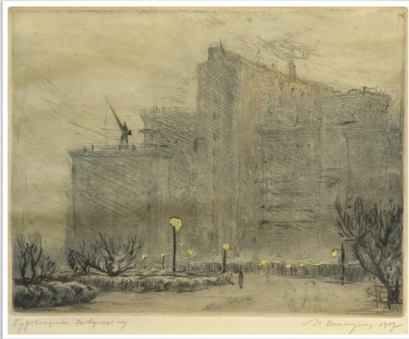
Шигима П. А. Будівництво університету. 1957.
