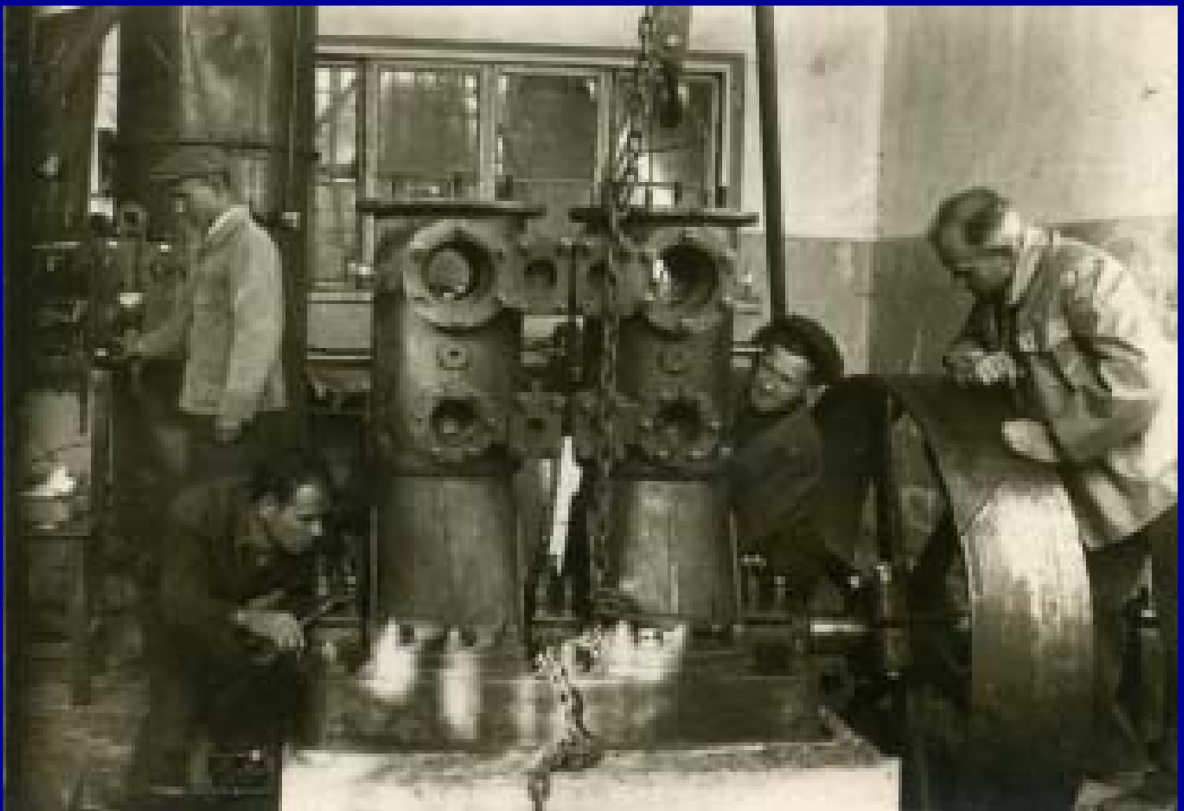
Ремонтні роботи на компресорі в кріогенній лабораторії УФТІ: крайній справа – Б.Г. Лазарев, зліва внизу – В.Г. Хоткевич, на задньому плані – О.Й. Судовцов. Кінець 30-х років [14].
